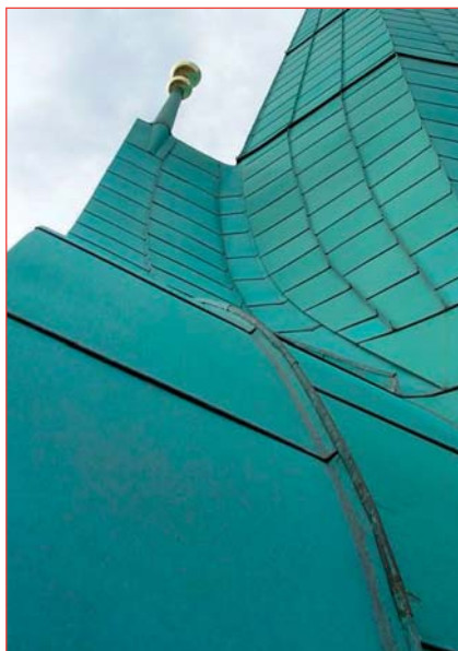
Das Kupferfalzdach aus vorpatiniertem Kupferblech «Tecu-Patina», 2004 durch Scherrer Metec AG erneuert.
