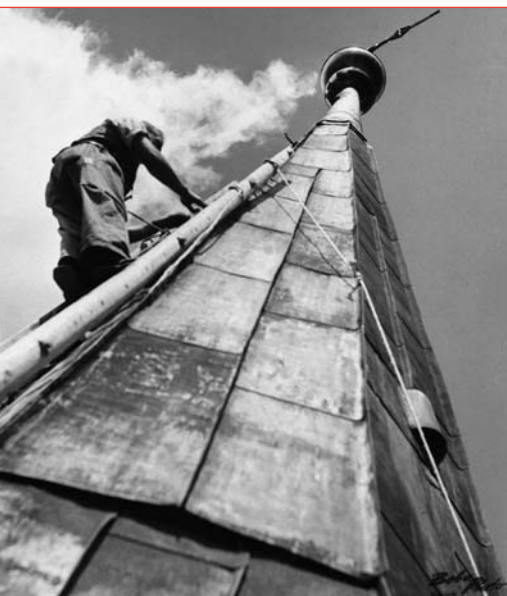
Reparaturarbeiten anno 1947 in luftiger Höhe.
